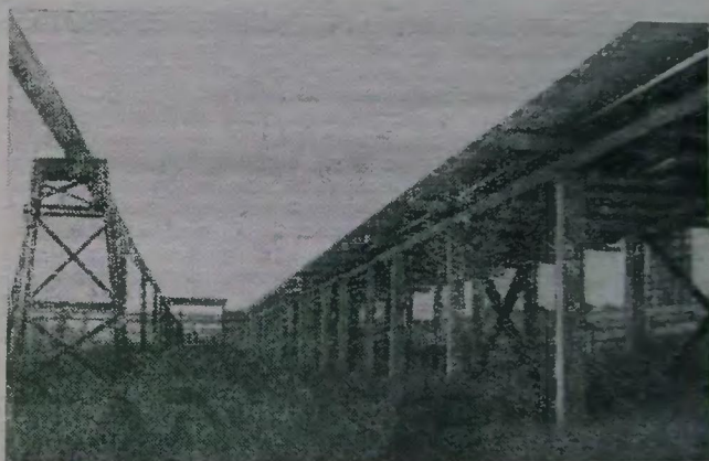
Рис. 27. Опоры под технологические трубопроводы из свай-колонн.
